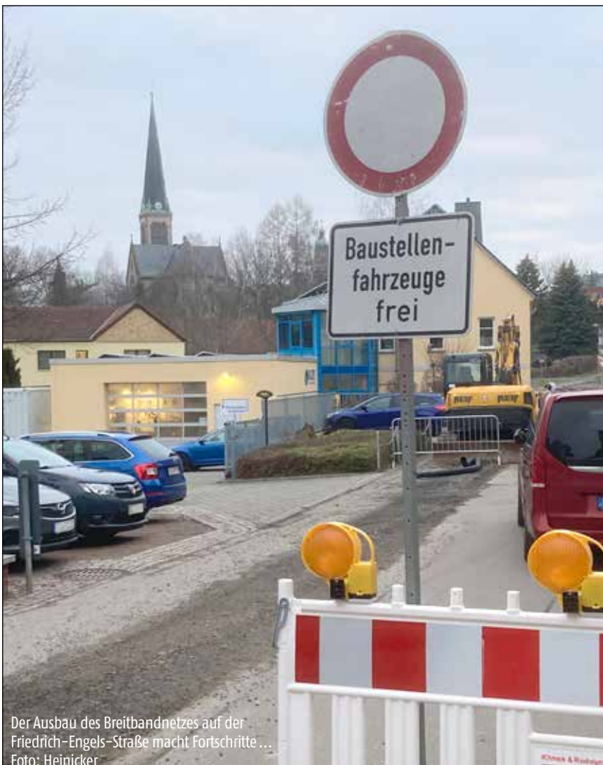
Baubeginn Abwasseranschluss in Dittmannsdorf Foto: JoLu
