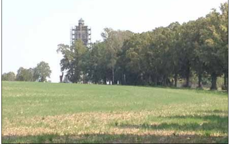
Die Sanierung des Aussichtsturmes soll bis Ende des Jahres abgeschlossen werden.
