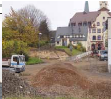
In vollem Gange sind die Arbeiten an der Brauhausstraße/Hermisdorfer Straße.
