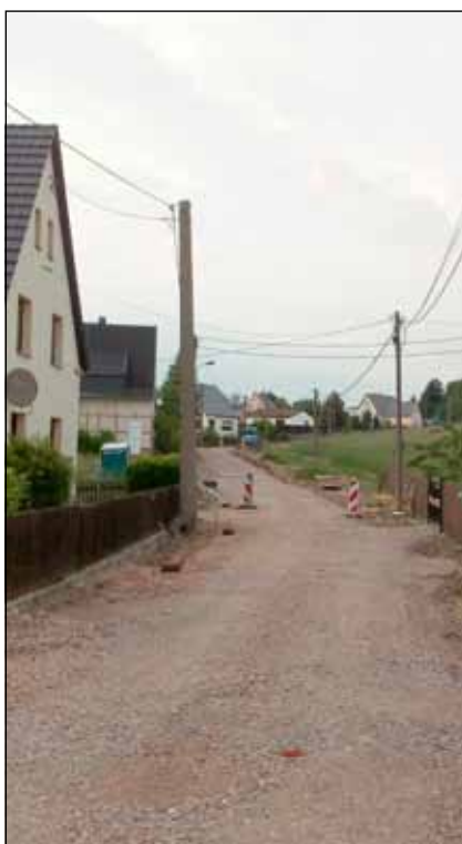
Der grundsätzliche Ausbau am mittleren Abschnitt des Eichberges schreitet planmäßig voran ...
