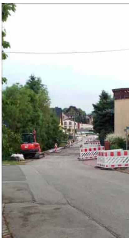
Ebenfalls gut voran kommt der 2. Bauabschnitt an der Sanierung der Lange-nauer Straße...
