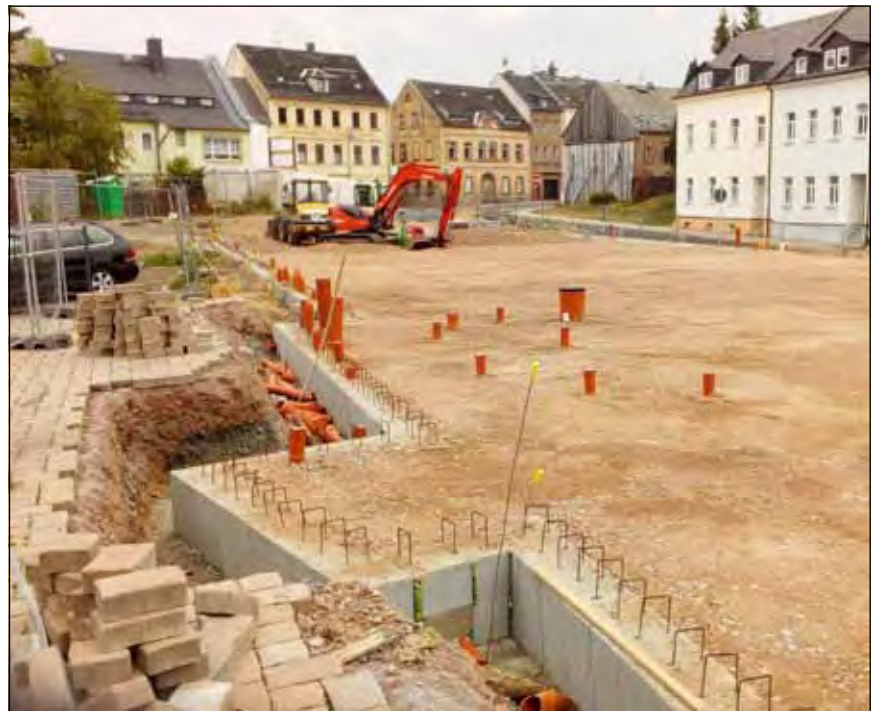
Der Neubau der Schulsporthalle geht weiter voran.
