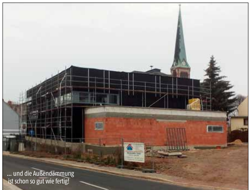
Der Innenausbau der neuen Schulturnhalle schreitet voran ...
