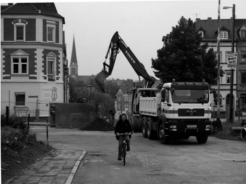
Bau der Bahnhofstraße und Mittweidaer Straße
