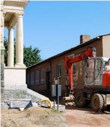
Rege Bautätigkeit an der Diesterwegschule. Die Außenanlagen werden grundhaft erneuert, dabei stieß man auf Altlasten (Schutt aus der Kaiserzeit), die den Fortschritt der Arbeiten ein wenig verzögerten.
