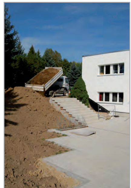
Bauarbeiten am Pfiffikusland geben voran – der neue Eingangsbereich ist fast fertig...
