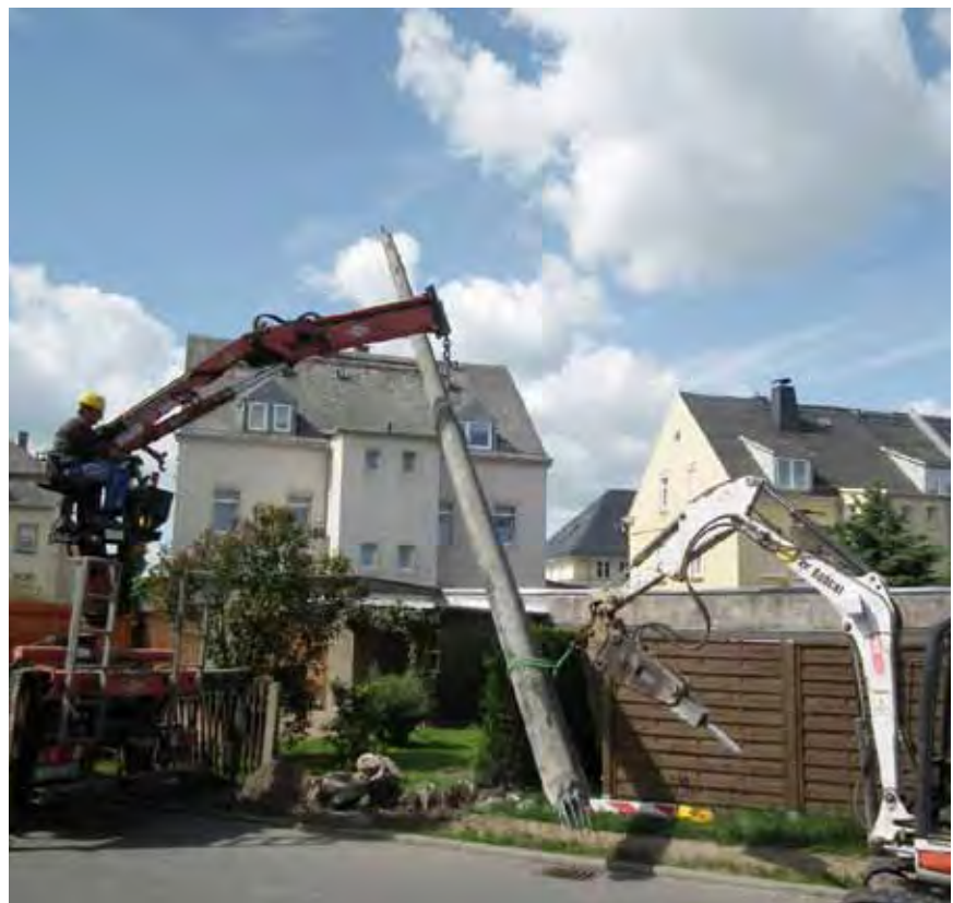
Abbau der ELT-Leitung am Oberen Hohlweg
