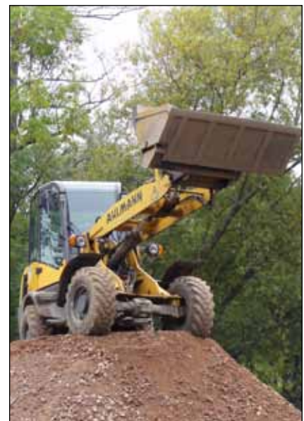
Mittagspause für einen Radlader... Die Bauarbeiten rund um den Buchberg sind in vollem Gange – der grundbaste Ausbau am Buchberg schreitet planmäßig voran. Abwasserleitungen, Energieanschlüsse und Straßenbelag werden erneuert. Fertigstellung voraussichtlich Ende Oktober.
