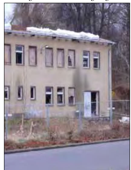
Der Abriss »Stern-Radio« beginnt in den nächsten Wochen.
