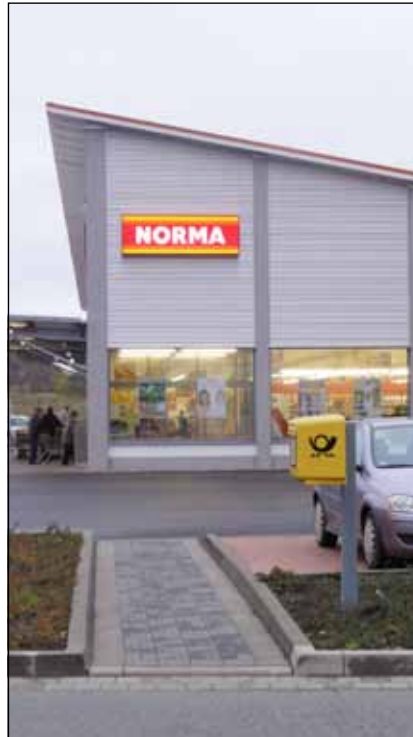
Auf Anregung von Anwohnern wurde von der Deutschen Post AG am neuen Standort des NORMA-Marktes, Rochlitzer Straße ein neuer Briefkasten aufgestellt.
